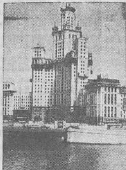
MASKVA. Daugiaaukščio pastato statyba krantinėje Ketelnickeskaja.
